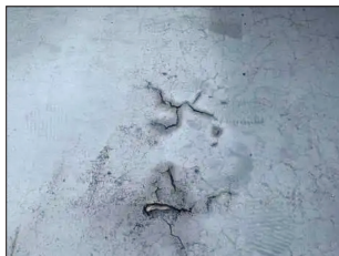
防水工事の再施工
