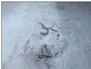
防水工事の再施工
