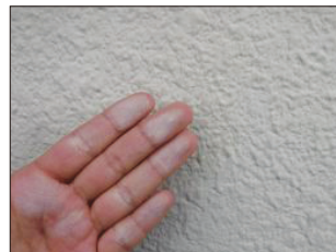
外壁の再塗装
